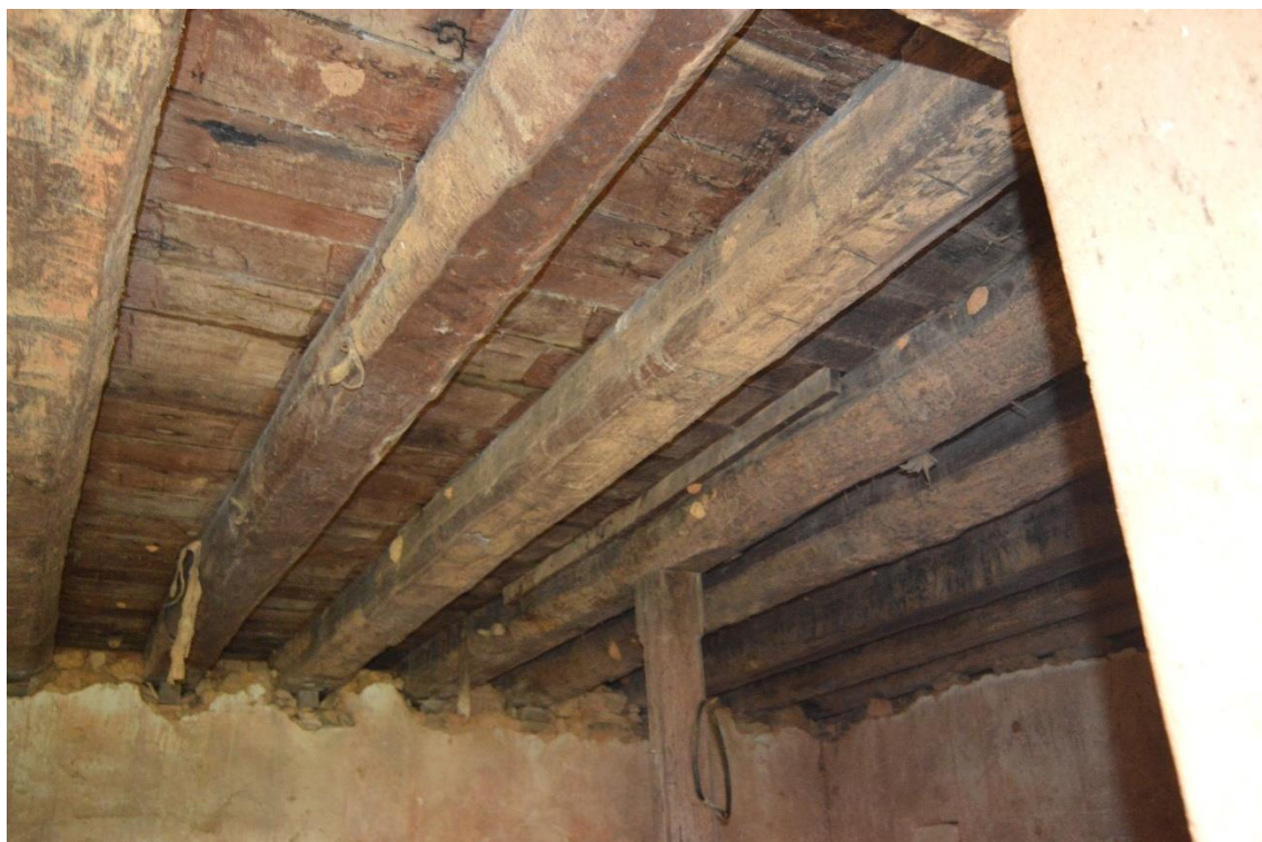
Barrotes vistos do porão, formando a base do piso da Fazenda Severino. Fotos: Suely de Deus, 2019
